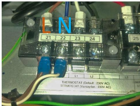
Abgriff der 230V+N für das Relais des Rundsteuersignals oder einer Zeitschaltuhr
